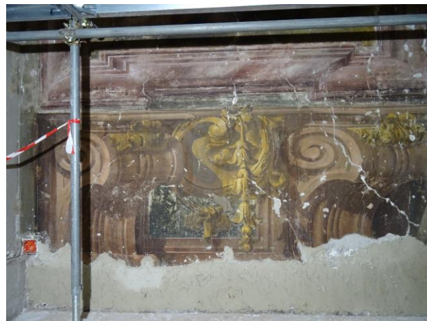
Estrazione salina condotta con impacchi di sepiolite ed acqua deionizzata
