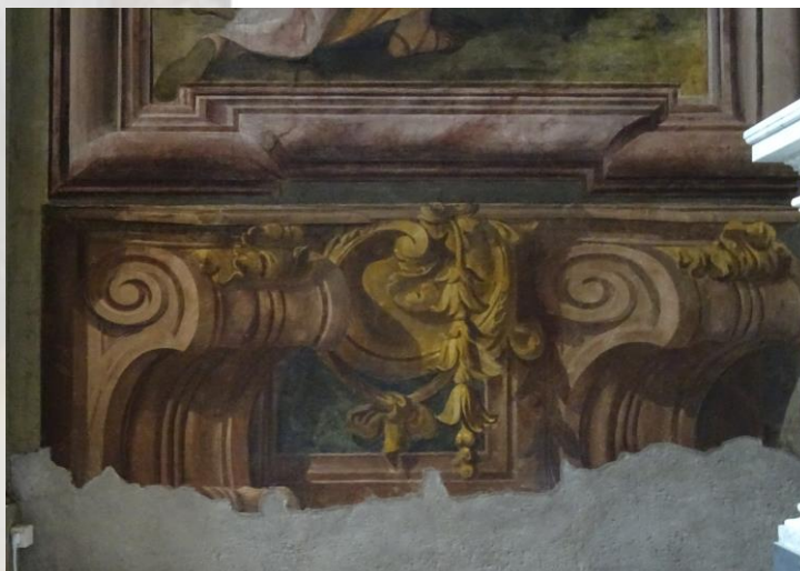
Post operam: dopo il consolidamento, la stuccatura della lacune e la reintegrazione pittorica
